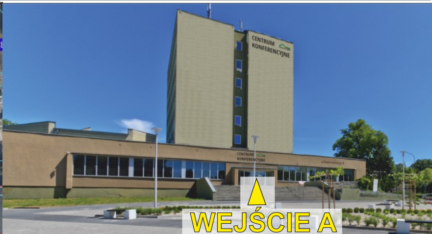
parter budynku A
